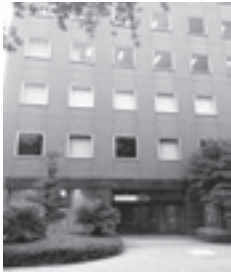
13号館正面玄関
